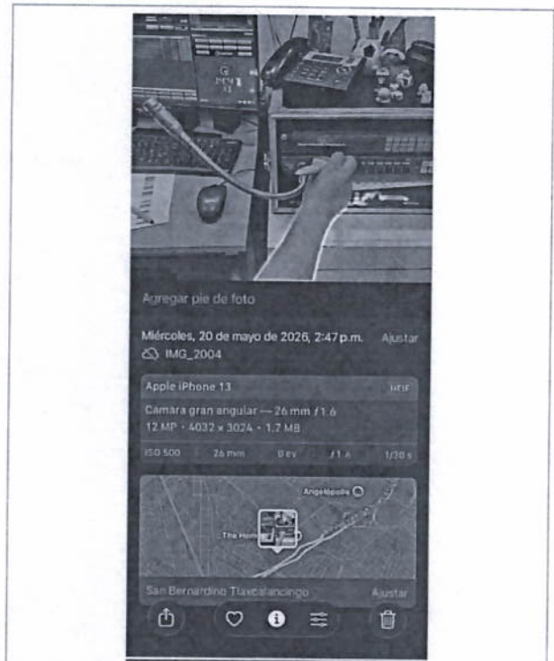
Limpieza de sistema de comunicación
